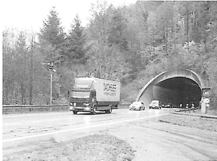
Der Hugenwaldtunnel wird – voraussichtlich 2012 – nicht mehr acht Monate, sondern nur noch zehn Wochen voll gesperrt. | Foto: Bernd Fackler
