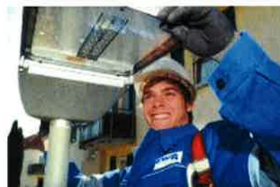
EWR-Mitarbeiter installieren seit Mitte August die neuen LED-Straßenleuchten. Foto: EWR
