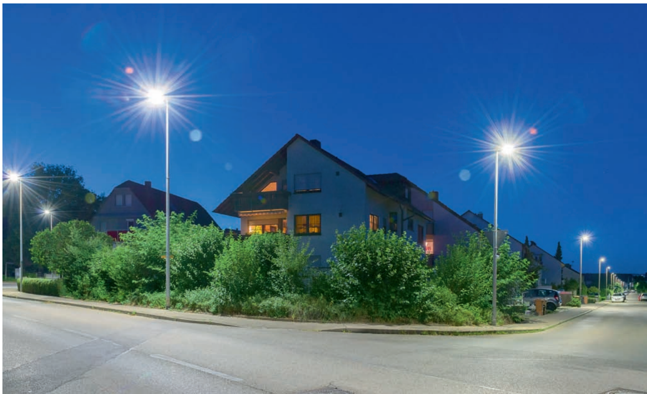
Die neue Straßenbeleuchtung in Unterensingen
